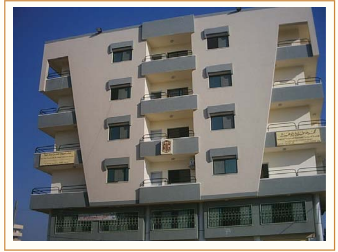
المبنى الذي تقع فيه مكاتب المجموعة - غزة
